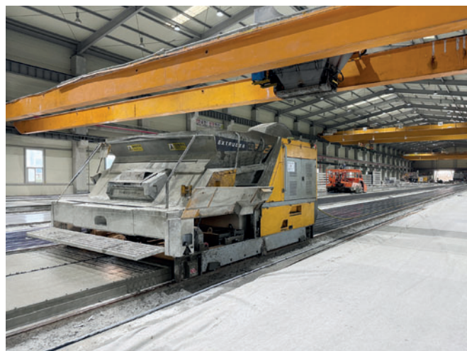
Экструдер EVO2 во время бетонирования двойной плиты длиной 2,4 м
