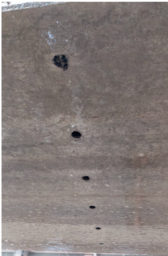
Дренажные отверстия, видимые на нижней стороне пустотных плит
